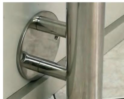
**Detalle del sistema de anclaje a pared mediante tornillos.**
